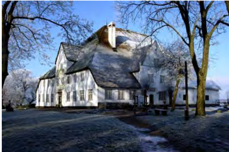
Figure 3: Roter Haubarg (Photo: Archäologisches Landesamt Schleswig-Holstein)
